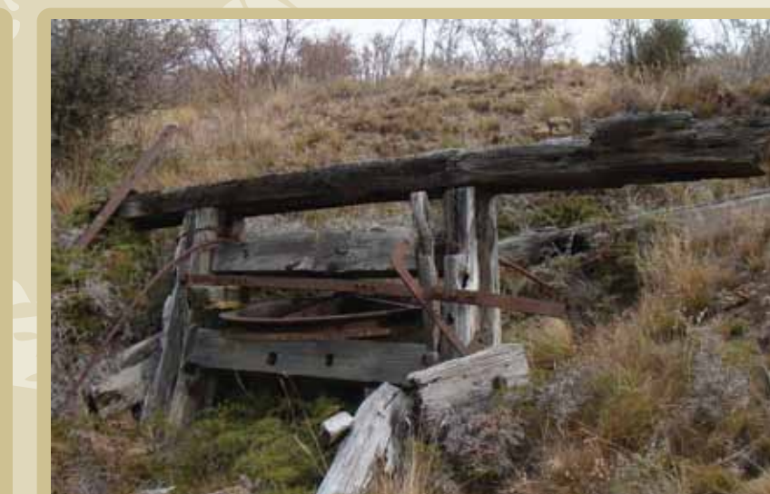
Cableway 'Bull wheel'
